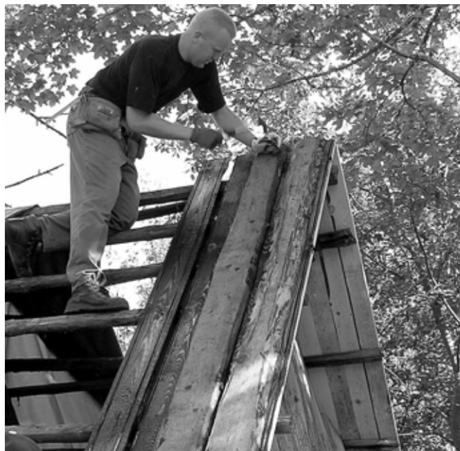
Kalle Uiboleht näitab laudkatuse löömist. Foto Ave Siilak
