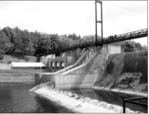
Renoveeritud Linnamäe HEJ sai tiitli Aastaehitis 2002 kui parim rajatis.
