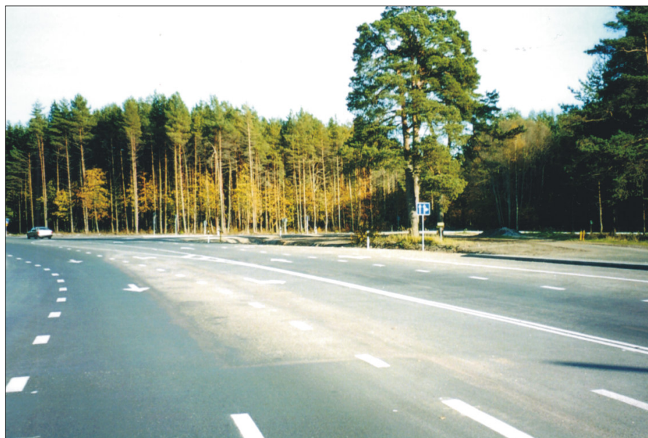
Seoses rajatava veekeskuse piirkonna detailplaneeringuga sai kogu ristmik korralikult renoveeritud ja liikleiajale ohutumaks muudetud.
