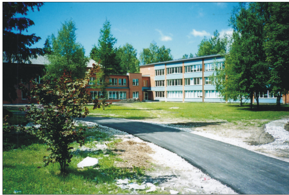
Maksumaksjale ligi 6 miljonit krooni maksma läinud Paikuse Põhikooli II etapi valmimisega said lapsed uue söökla koos õppekorpusega.
