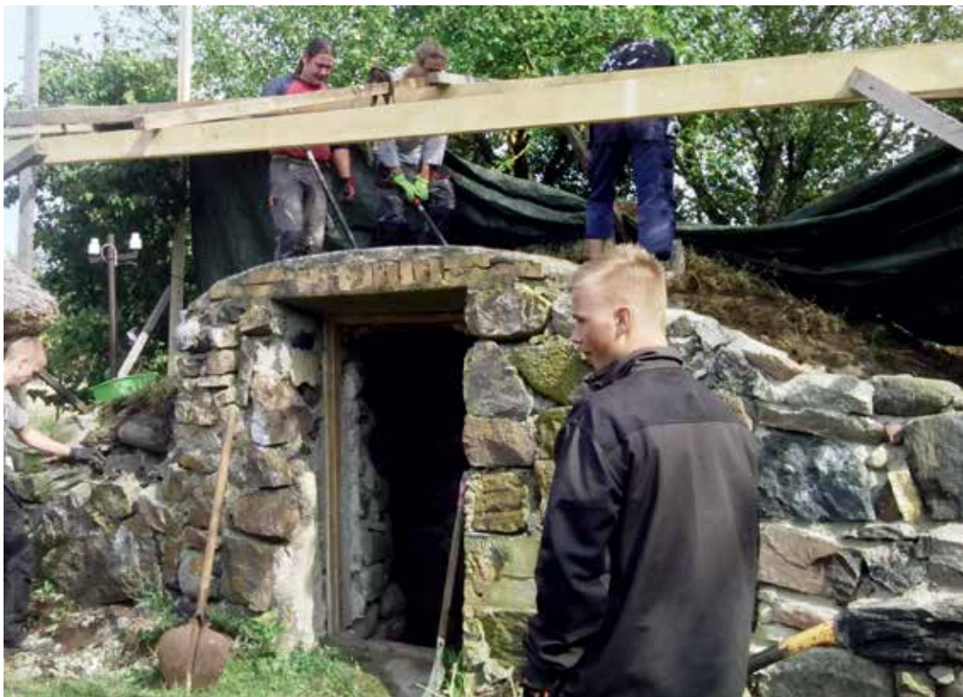
Foto 1. Keldri fassaadi lahtivõtmine esimesel päeval. Markus Pau foto.
