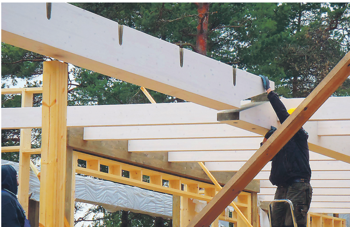
TÖÖMEHED on ametis laetala paigaldamisega.
