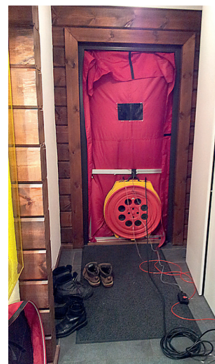
MAJA õhupidavuse mõõtmine (rõhutest) blower-door -testiga. FOTOD: TIMBECO WOODHOUSE OÜ
