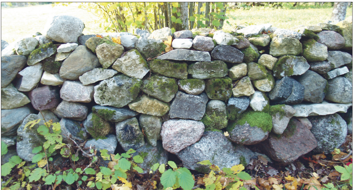
Kui taastatakse liiga lühike jupp aeda korruga, võib ladu hakata jooksma diagonaalselt. Parem on korruga ette võtta 8–10 meetrit.
