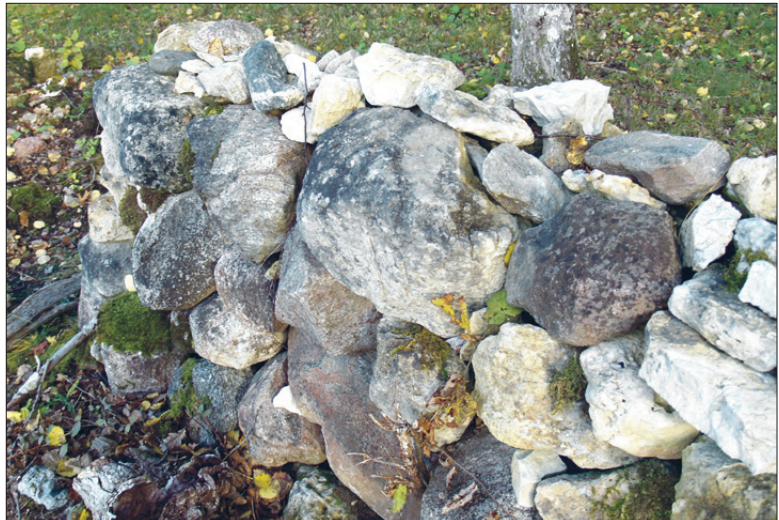
Liiga suured kivid asetatakse liiga kõrgele. Nii tekib oht nende väljavajumiseks.
