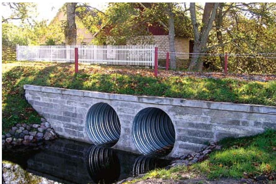
Foto 13. Truubi paekivimüüritisega otsak – Ø120 ja Ø140 cm
