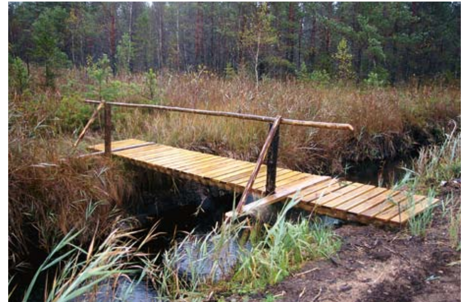
Foto 18. Puitpurre pikkusega 4–7 m
