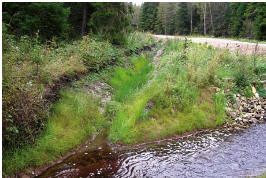
Foto 3. Erosioonitõkkematiga kraaviühendus
