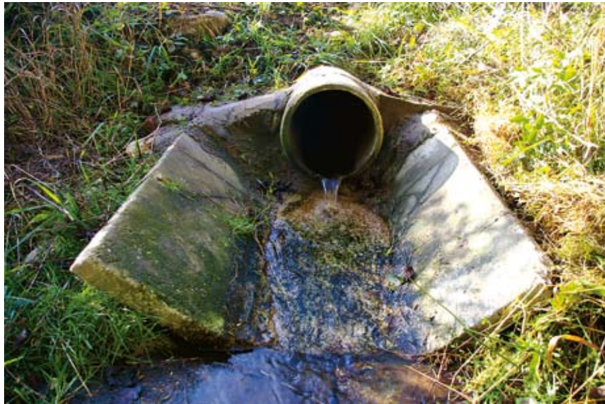
Foto 9. Drenažikollektori suue Ø130 mm ja suurem
