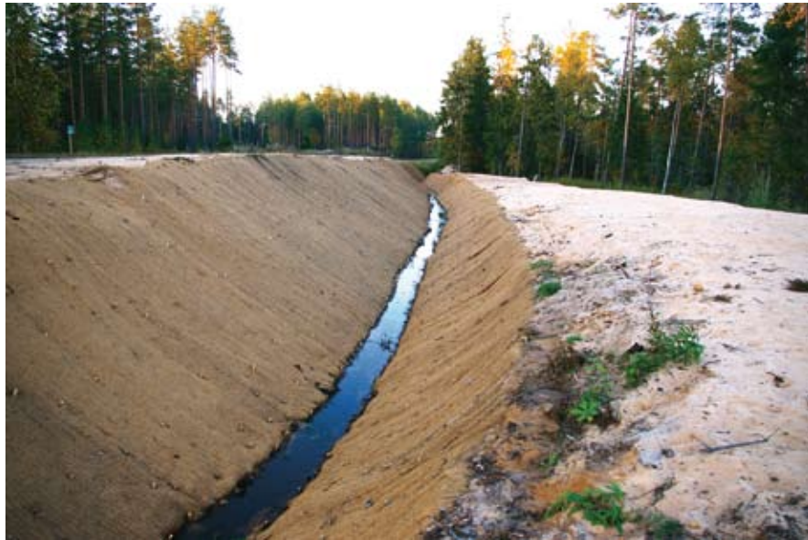
Foto 1. Nõlva kindlustamine erosioonitõkkematiga
