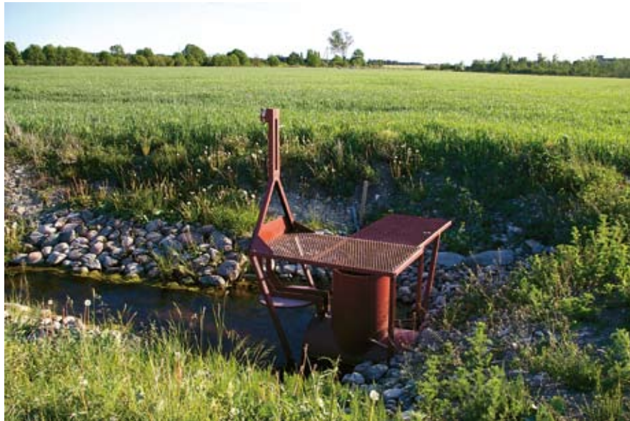
Foto 17. Truubi klappregulaator
