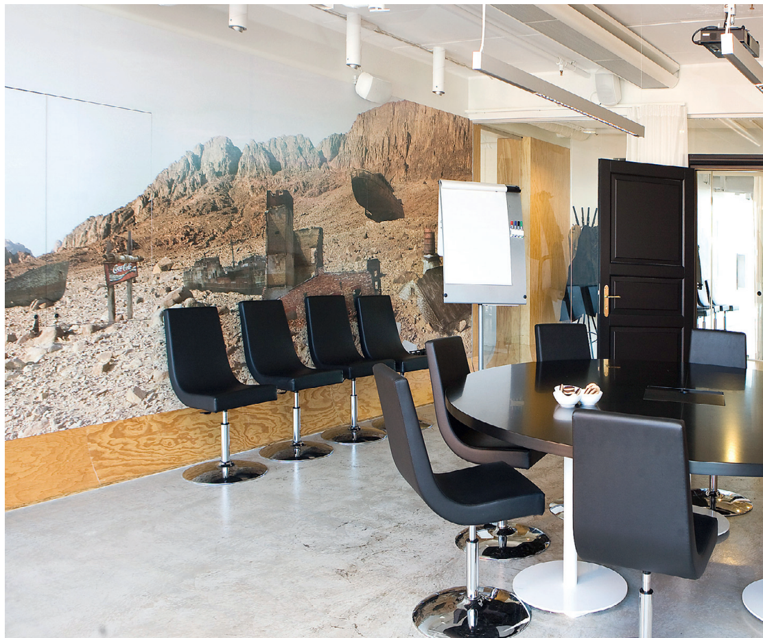
Materjalidest eelistati kabinetiseinu planeerides klaasi ning tugeva puusüümustriga männivineeri, kuhu istutati klassikalised profiiluksed.
