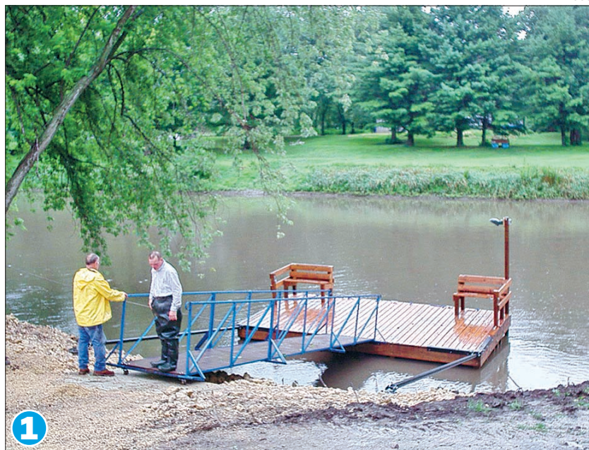
Ujuv nelinurkne paadisild, mis ankurdatakse kaldasse, kuid mis nõuab trappi.
