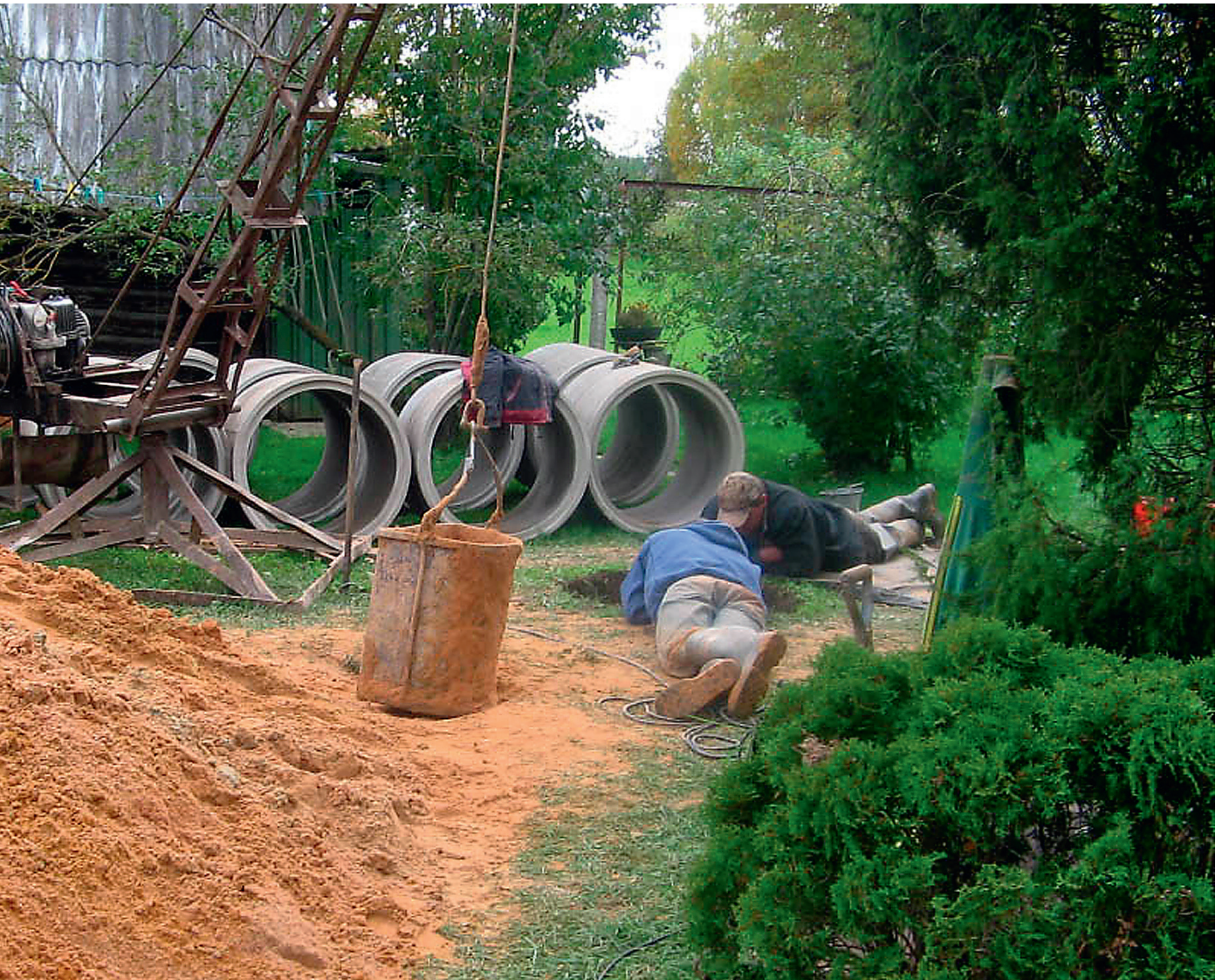
► Endale uue salvkaevu ehitada lasknud Armaid Jõgeva kiidab kolme tublit Valga meest, kes viie päevaga ehitasid valmis umbes 17,5 meetri sügavuse kaevu, kuhu paigaldati 22 kaevurõngast. Kaevu seinad on liivakivist.
