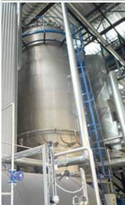
Spiraaltorudega püstine termaalõlikatel (keskel). Coiled tubing upright thermal oil boiler (in the middle).
