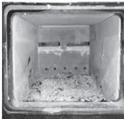
JOONIS 8. Täiustatud ja isoleeritud kolle õhuavadega tagaseinas. Improved and insulated hearth with air vents in the back wall.
