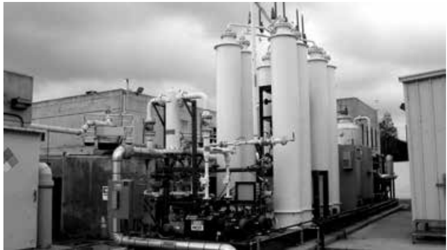
Joonis 1. Kõikuvrõhuadsorber Escondido reoveepuhastusjaamas, Californias, suudab varustada gaasiga 1200 majapidamist.
