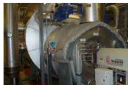
1 MW el võimsusega turbogeneraator. Turbogenerator with electrical capacity 1 MW el .
