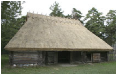
Joonis. 2 Taastatud rookatus. Restored thatched roof
