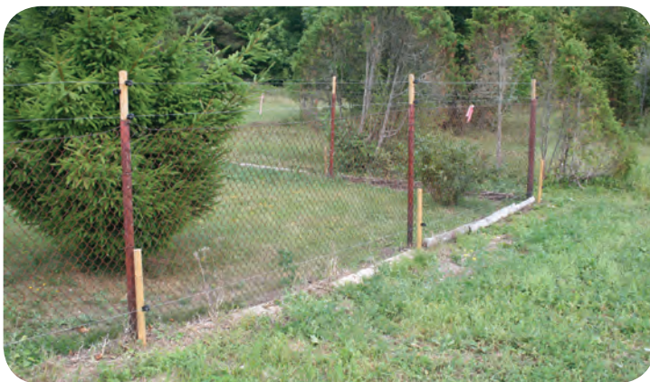
Vana võrkaia saab lihtsalt turvalisemaks täiustada üles ja maapinna lähedale lisatud elektrikarjuse traatidega – aed ümber mesila Harjumaal. Foto: U. Treier
