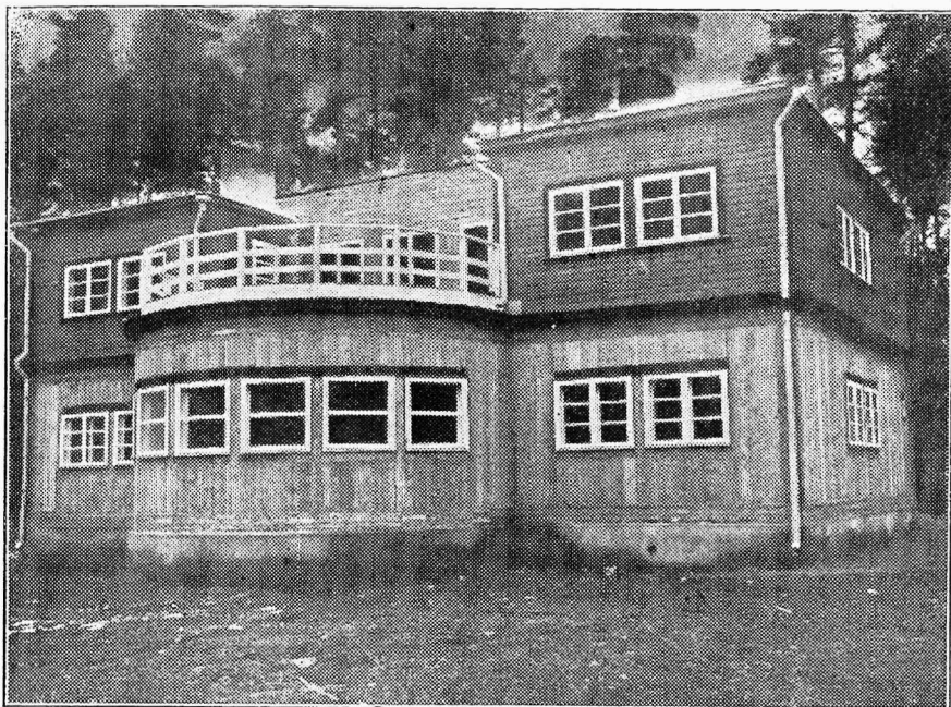
Maja fassaad platsilt vaadates.
