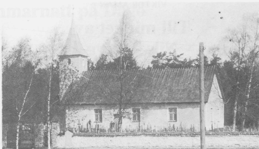
Rosleps kapell (före renoveringen).
