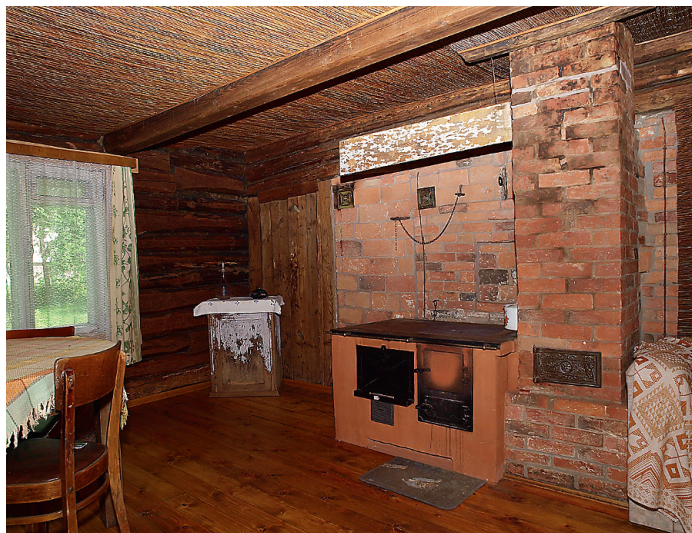
VAHETATUD on põrand, puhastatud seinad ja lagi ning renoveeritud pliit ja soemüür.
