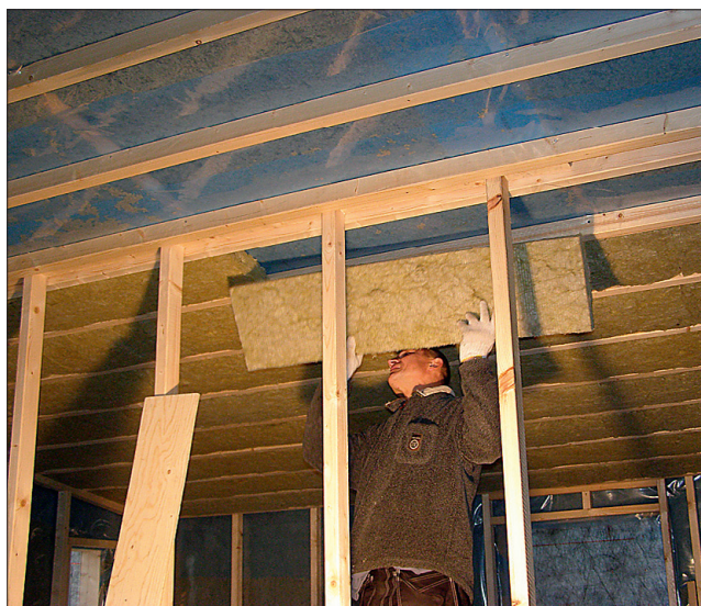
► Vahelagede soojustamiseks kasutatakse aga 100 mm pakust kivivilla.
