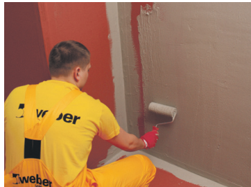
Hüdroisolatsioonimassi weber.tec 822 seinale kandmine maalirulliga
