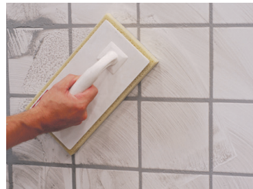
Plaadipindade puhastamine vuugisegust
