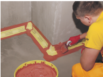
Hüdroisolatsioonilindi weber.tec 828 paigaldamine
