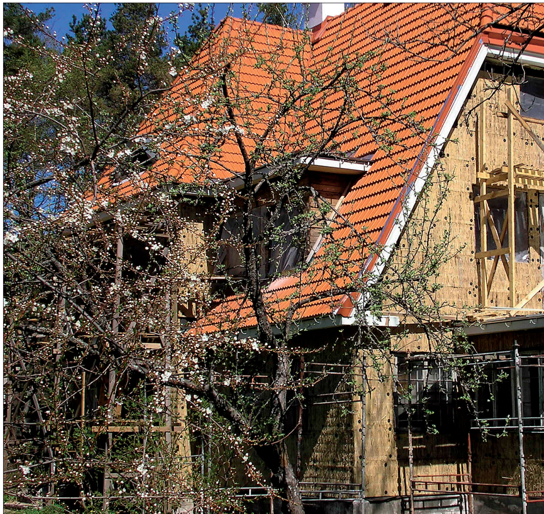
► Selle 1929.–30. aastal Nõmmele ehitatud maja renoveerimisel kasutati maja soojustusena ja krohvialuse pinnana 5 cm paksust pilliroomatti.
