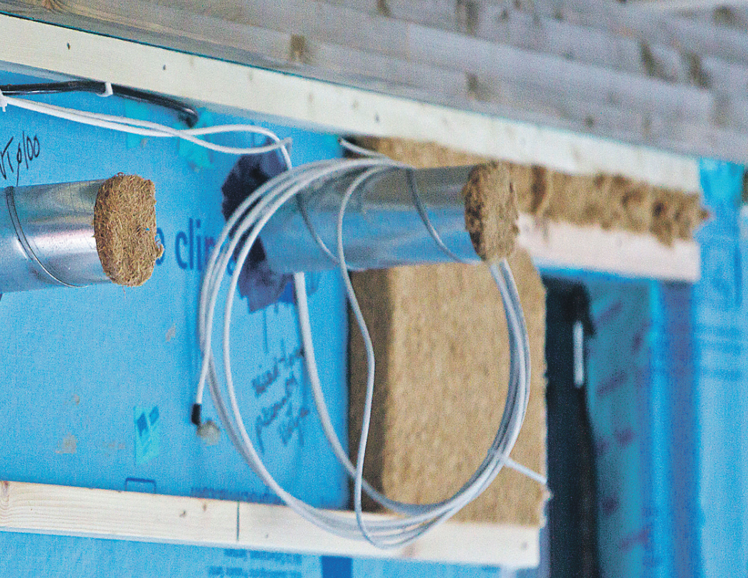
LÄBI seina toodud ventilatsioonitoru. Siin on oluline läbiviigu tihendamine. FOTOD: RAUL MEE
