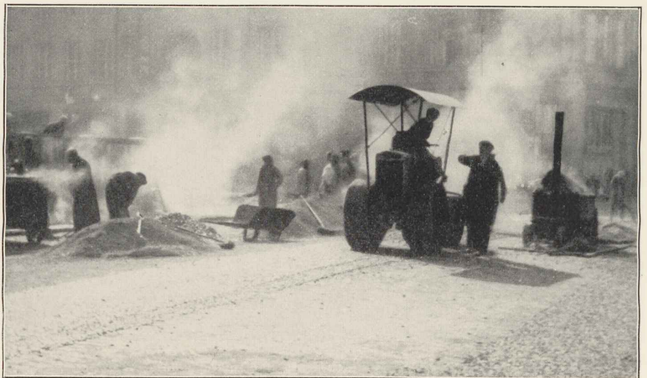
Põlevkivi-bituu- menist tänava- katte valmista- mine Tallinnas.
