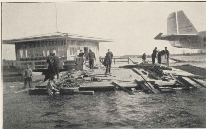
Vesilennukite maandmissilla ehitustööd Tallinna eralennuväljal.
