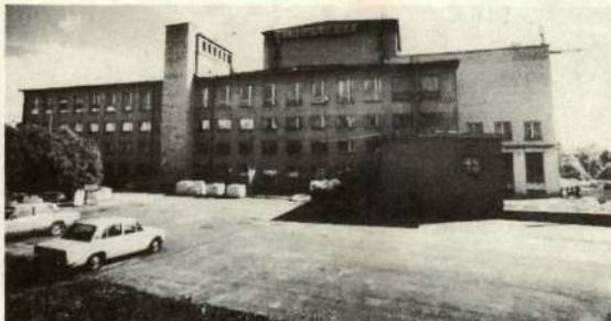
Lõpetamata teatrimaja? 1967. aastal osaliselt vastu võetud «Vanemuise» hoone kujuteldavate proovi- ja maalisalide, administratsiooni ja loominguiliste töötajate ruumide, töökodadega jne. Juba 1968. a kerkis vajadus «Vanemuise» hoone laiendamiseks!
