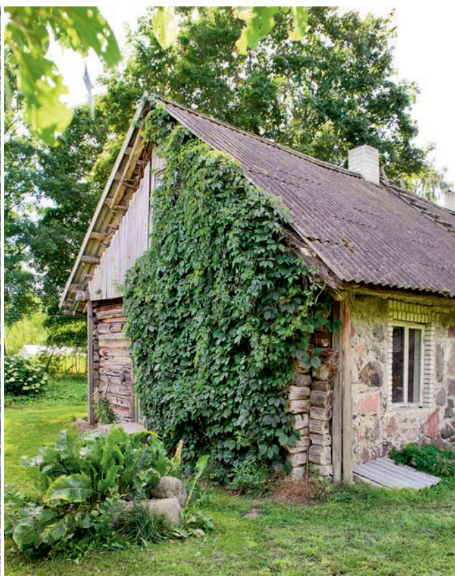
Läbimädanenud palksein laoti uesti üles maakividest.
