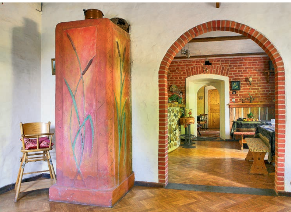
Kohvikuuste võlvi tellised valasid praegused kohvikuomanikud ise. Kunagi oli samas kohas Allikukivi tellisetehas, kus kivid valmisid samuti käsitööna. Vanast plekkahjust, mida keegi ei märganud, sai savi ja liiva seguga küttekeha ning ruumikaunistus.
