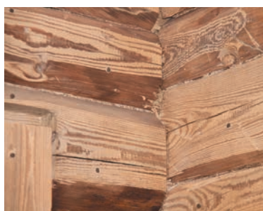
Palksein enne ja pärast soodapuhastust.
