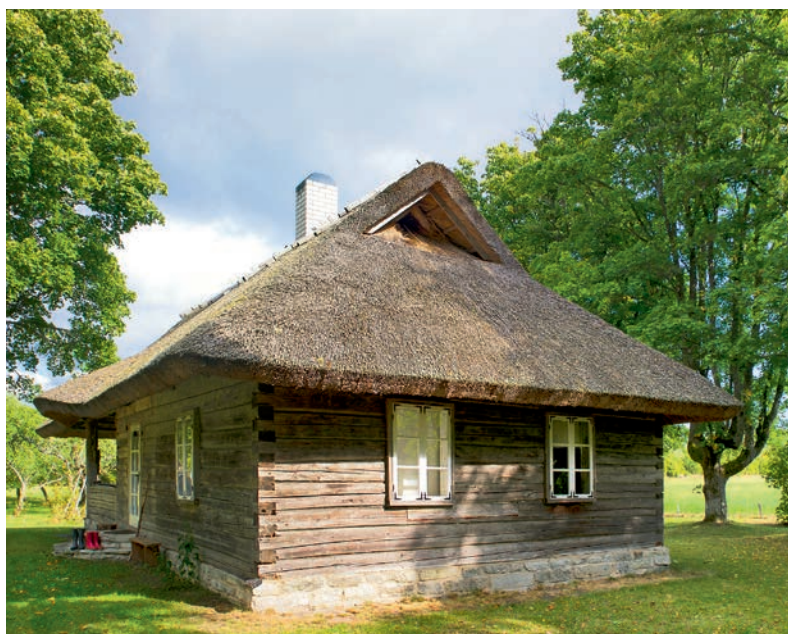
Elumaja rookatus sai tehtud vimkaga ehk rookatuse äär pandi looklema ja lainetama, nagu muinasjutu illustatsioonidel.
