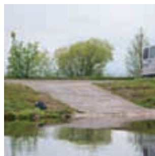
4 Kulgu sadam. Slipp asub kuulsate vesigaraažide läheduses. Kruusale valatud betoonkate, lähed vee all üle kruusaks. Järsk slipp, slipi taga sügav vesi. NB! Slipist mõnekümne meetri kaugusel garaažide pool on vee all betoonplokid mille otsa võib paadi madalama veeseisu korral puruks sõita. N 59°20'43" ja E 28°10'24"
