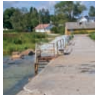
5 Käsmu Betoonpaneelidest slipp N 59°36,08' E 25°55,49'
