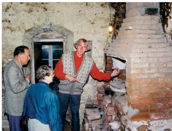
Jüri Kuuskemaa tutvustamas veesoojendus-pajaga koldealust mantelkorsten-köögis oma vanavarakolleksiooni suurimas objektis, Haapsalu vanimas säilinud kodanikuelamus
