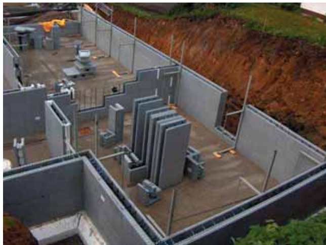
Wolf Thermo Module'i seinakonstruktsioon
