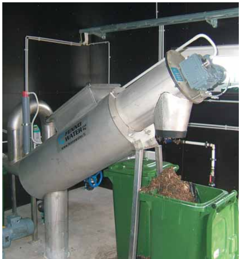
Joonis 4. Tõravere reoveepuhasti trummelsõelur
