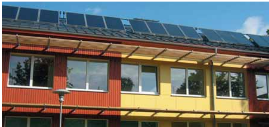
Päikesevarjud hoone fassaadil
