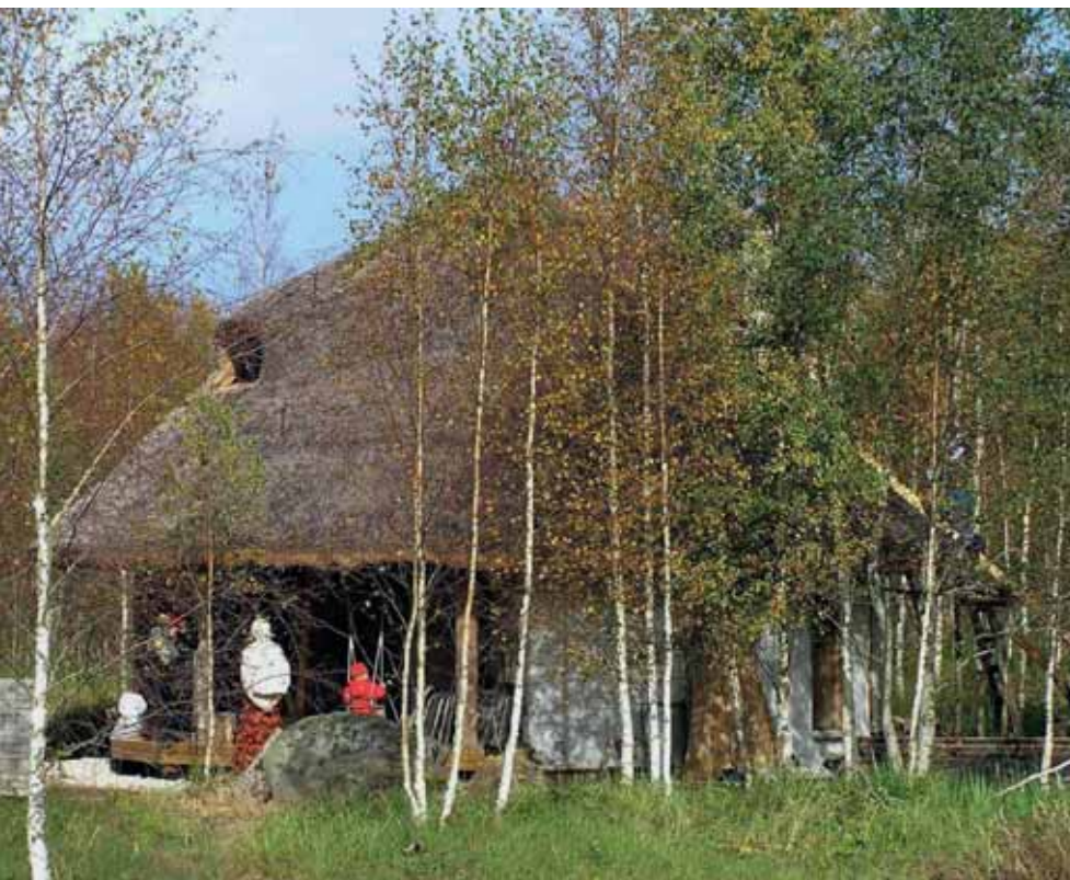
Hetkel ehitatakse ökoküla naabruses roopallidest ja rookatusega laste mängumaja. Ka selle rajamisel on lähtunud ökoehituse printsiipidest: materjalid on looduslikud ja loodus ümber maja on säilinud algsel kujul
