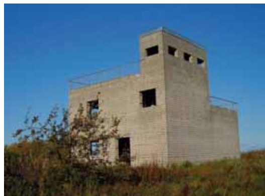
Linnukaitseala vaatlustorn. H. Treiali foto
