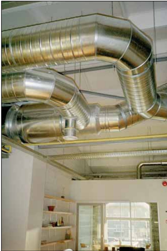
NÄHTAVALLE JÄETUD VENTILATSIOONITORUD RUUMI LAES
