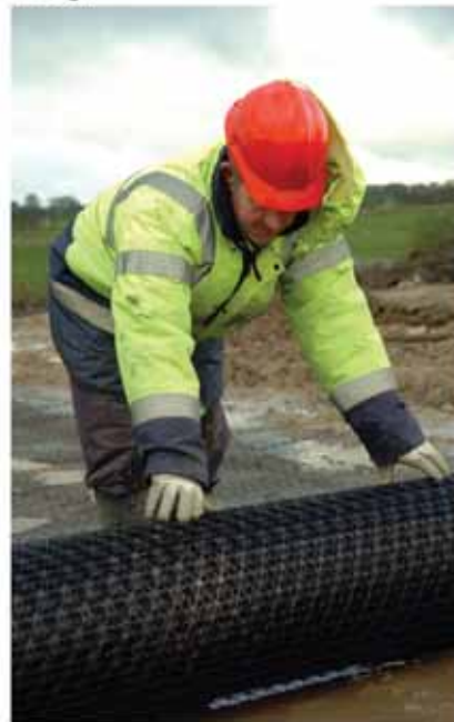
TriAxil lahtirullimine objektil
