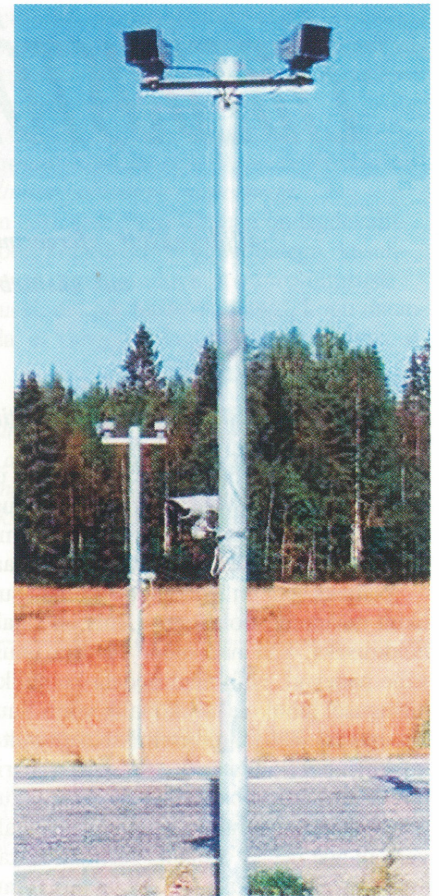
Piltidel: "Uks" aias põtrade jaoks ja detekteerimis- ning hoiatussüsteem teel 5 Soomes Mikrolainedetektorid ja infrapunadetektor ava kõrval
