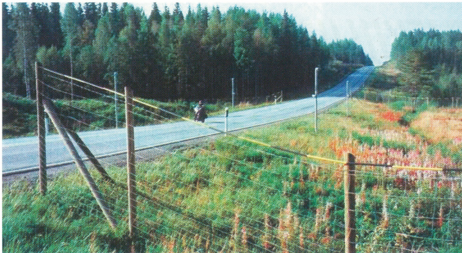
Piltidel: "Uks" aias põtrade jaoks ja detekteerimis- ning hoiatussüsteem teel 5 Soomes Mikrolainedetektorid ja infrapunadetektor ava kõrval
