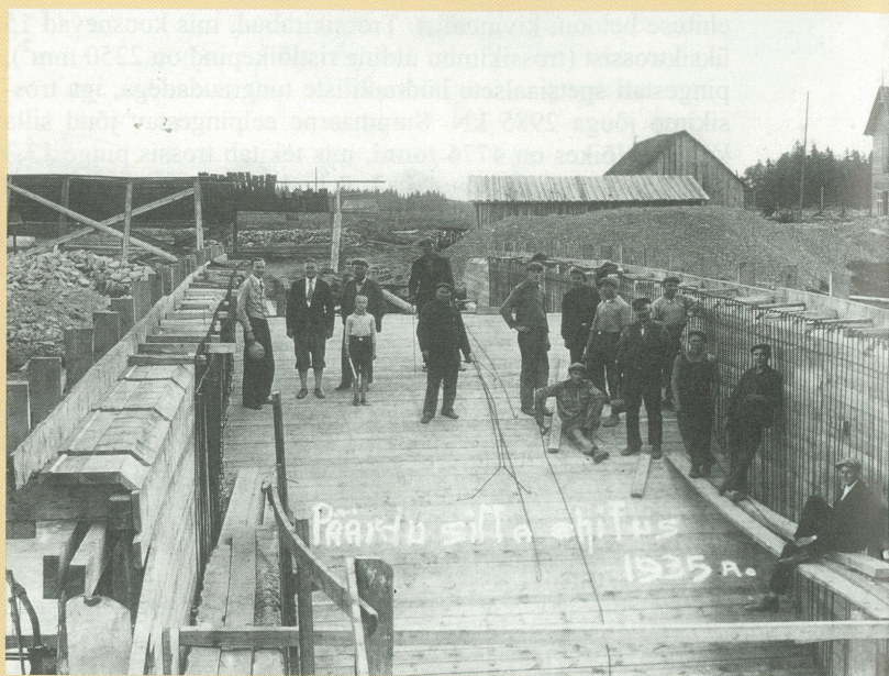
Ülemisel pildil: Päärdu silla ehitamiselt 1935. aastal. Kaarsilla raketis on valmis.
