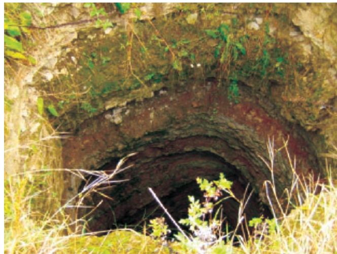
Lahtine kaevanduse ventilatsioonišaht Kukrusel
