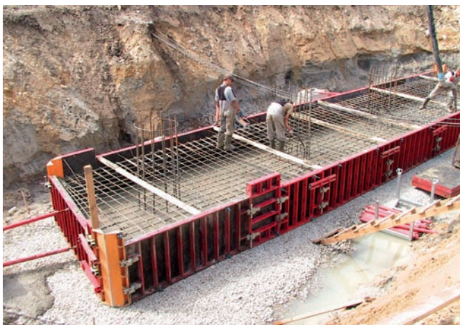
Viadukti vundamendi rajamine Vaida-Aruvalla teelõigul Tartu maanteel. Foto: Kristjan Reimets, 2007
