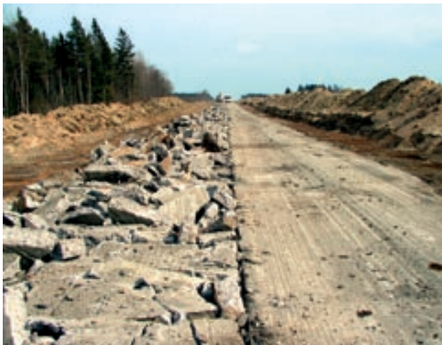
Vanast tsementbetoonkattest pool lõhutud. Foto Veiko Juudas
