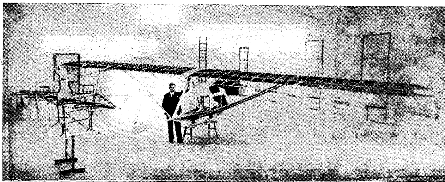
Tallinna Tehnikumi üliõpilaste poolt ehitatud purilennuk enne riidega katmist.
