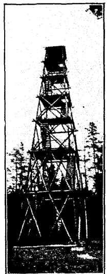
Kaiavere metsk. vaate-torn. Kõrgus 23 m. Foto J. Velbaum.
