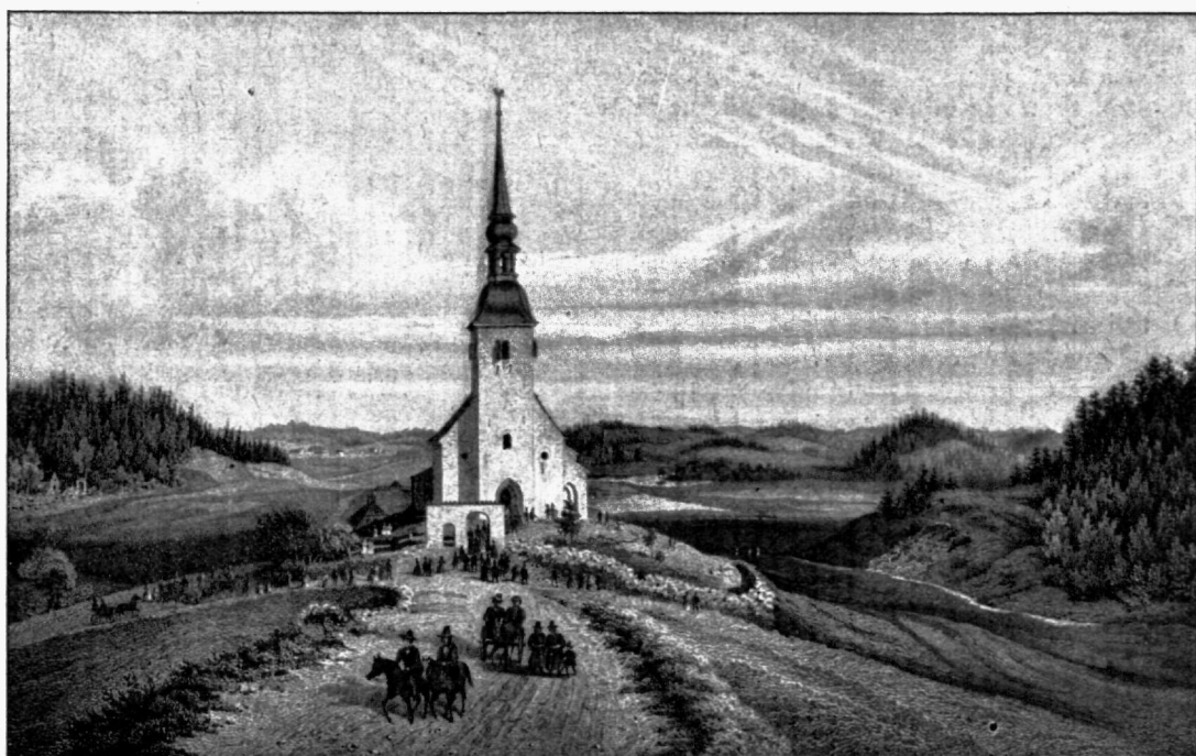
Otepää kirik umbes 1860. a. W. S. Stavenhageni joonistus
