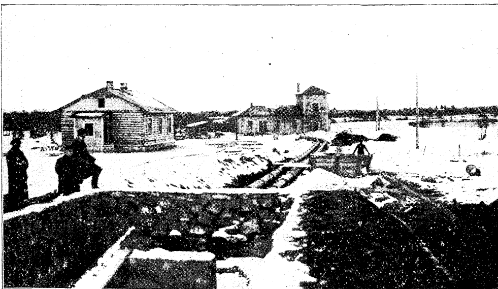
Kanaali algus Piirital. Taga pumbamaja, lähemal elumaja. On näha kaks toru, mille kaudu vesi Piirita jõest kanaali pumbatakse
