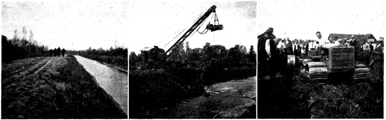
Vasakul: Juurepääsu tee ja magistraalkraav Haeskva asunduses. Keskel: Ekskavaator töö. Paremal: Uudismaa künd
