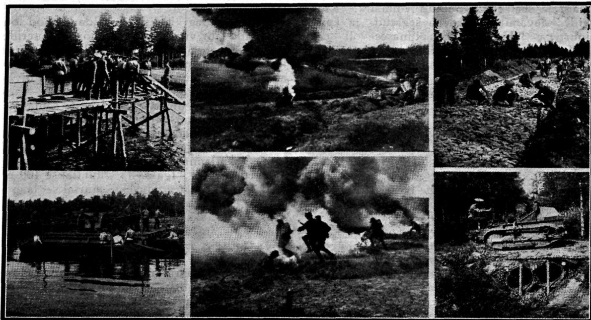
Ülalt vasakult: Silla ehitamine raamtagedel inseneriväe laagris 1. ja 7. jalav-rü. pioneride poolt. — Lahingdrill teegipildujatega. — Kivitee ehitamine inseneriväe laagris. Tee aluse tegemine paekividest. — Pioneride ja suurtükiväelaste jõe ületamise ühine õppus. Raske välisuurtüki ja hobuste parvetamine üle jõe pontoonidest parvel. — Rünnak suitsukatte varjul. — Sild kantsikorvidest üle kraavi raskete koormate jaoks.
