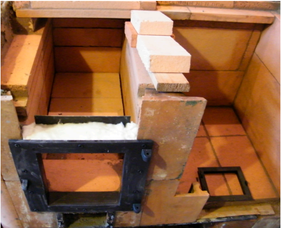
Joonis 2. Pliidi pilukolle, milles saab puhtalt põletada kuni 3,7 kg puitu (Foto Lauri Lõhmus) Figure 2. Umwelt-Plus fireplace for clean burning of 3,7 kg wood
