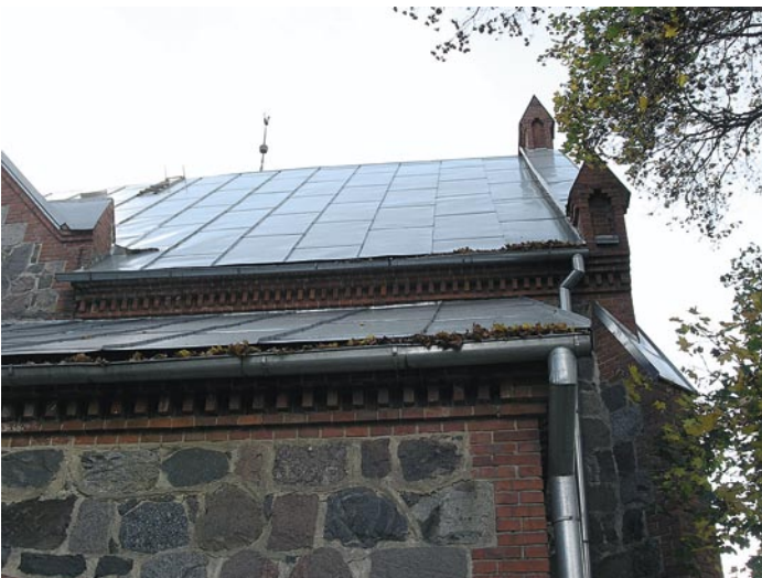
15. Puhastamist vajavad vihmaveerennid. Foto K. Tooming
