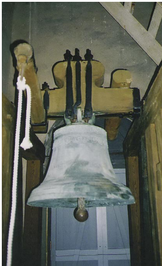
52. Helistamisel pannakse kell koos kandmikuga kiikuma kandmiku küljes oleva pulga külge seatud nõörist või trossist tõmmates. Foto T. Mäeväli
