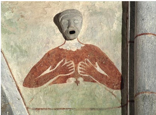
24. Võlvidele kogunenud vee ärajuhtimiseks mõeldud veesüliti on ühtlasi ventilatsiooniava. Foto P. Säre
