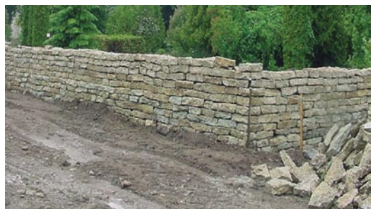
70. Piirdemüüri korrastamine sama materjali ja samade vōtetega, mida kasutati müüri ehitamisel. Foto I. Māesalu
