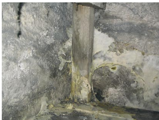
61. Niiske kivimüüri vastu asetatud puidus tekkinud seenkahjustus, mida on ka palja silmaga näha. Foto U. Kallavus
