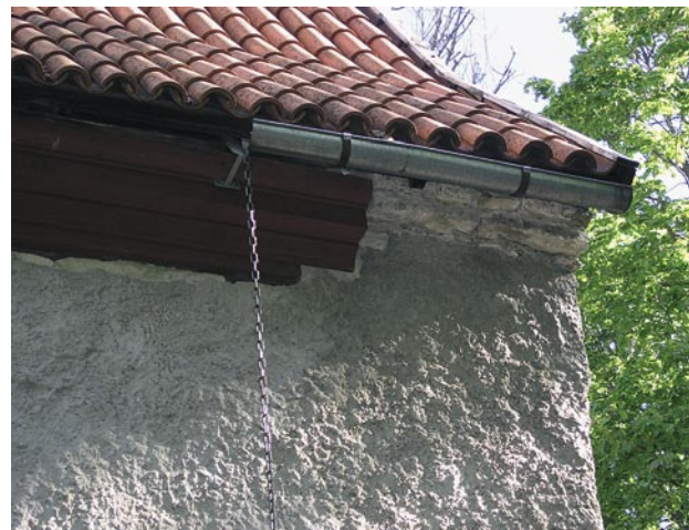
16. Räästarennile riputatud kett, mis asendab suurepäraselt vihmveetoru. Foto K. Tooming
