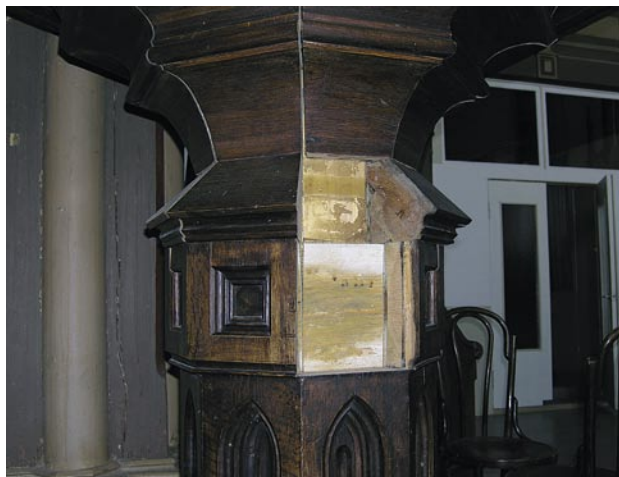
57. Ühendustest lahti kuivanud kantslijalg. Foto K. Tooming
