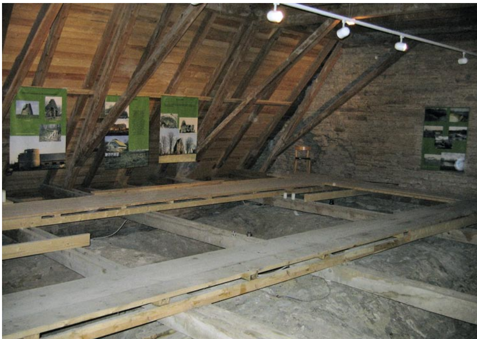
22. Puidust käiguteed ja elektrivalgustus võlvidepealsel. Foto L. Kurik
