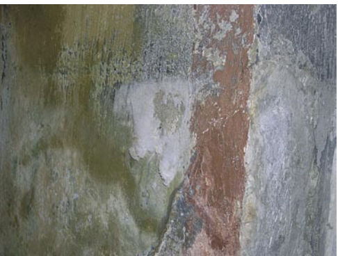
20. Seintele valge vatitaolise kihina kristalliseerunud soolad. Foto K. Tooming
