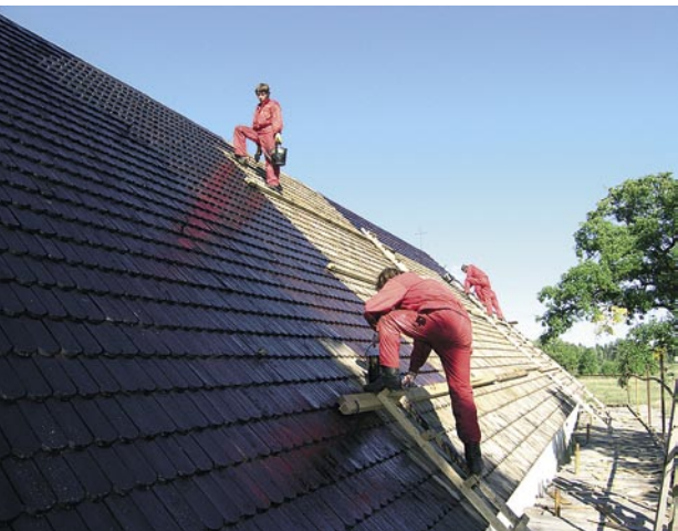
9. Kimmkatuse tõrvamine. Mitmekesi tehes läheb töö kiiremini. Foto K. Tooming
