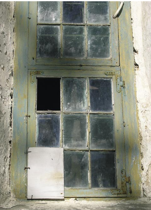
28. Ajutiselt vineeritükiga kaetud purunenud aknaruut. Foto K. Tooming
