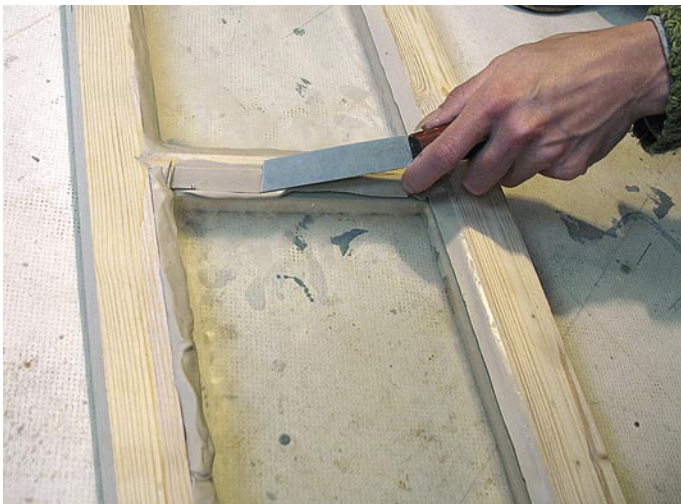
29. Kiti silumine spetsiaalse kitinoaga. Foto K. Zova
