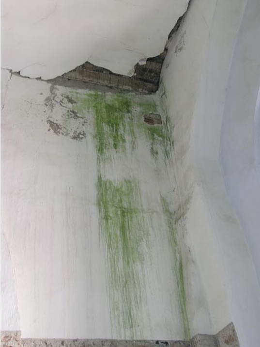
58. Liigniiskuse allikas kirikus. Foto K. Tooming
