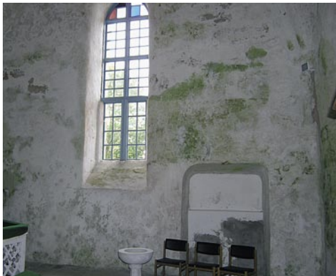
18. Seinte liigniiskusest märku andev rohevetikas. Foto K. Tooming
