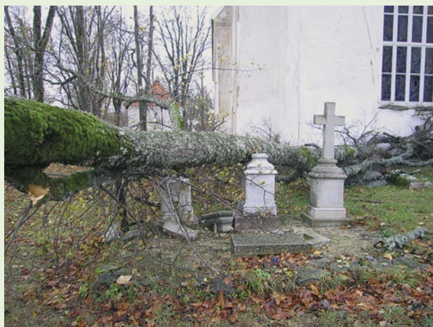
71. Tormiga murdunud puu on kahjustanud nii hauatähiseid kui ka kirikuhoonet. Foto K. Tooming
