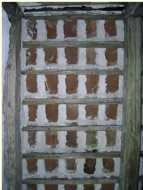
12. Altpoolt lubimördiga määritud kivikatust. Lubimördiga määrimine teeb katuse vett ja tuisku pidavaks. Foto K. Tooming
