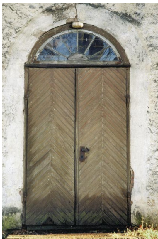
27. Pidevalt ukse alaosale pritsunud vihmavee tõttu aja jooksul tugevalt määndunud puit. Foto K. Tooming
