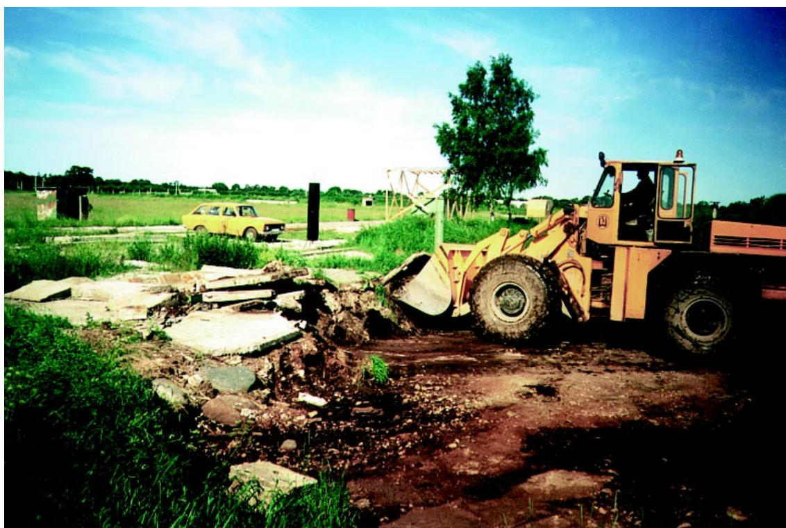
2 – Samiiniga reostunud pinnase teisaldamine Keila-Joa raketibaasis. Toomas Lambuti foto.
