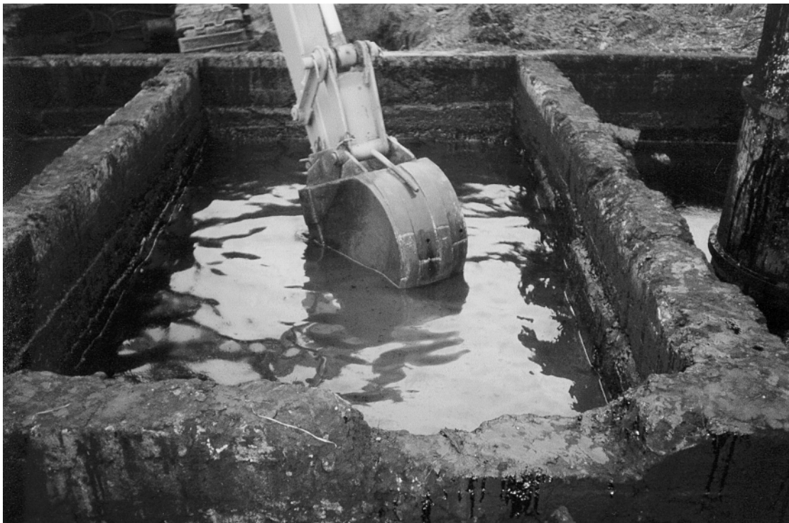
Foto 16. Paldiski keskkatlamaja amortiseerunud õlipüüdja puhastamine. Hugo Tangi foto.
