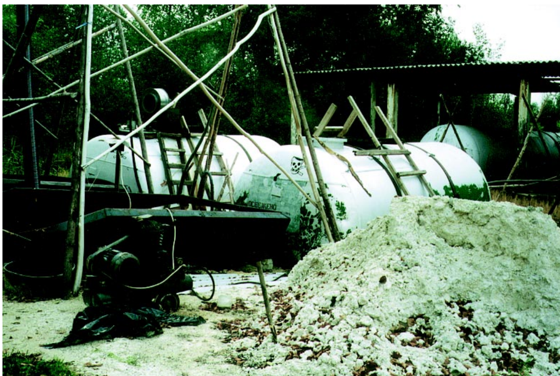
1 – Raketikütuse happeline komponent melanž oli Raadil erimetallist kütusemahutites. Anto Raukase foto.
