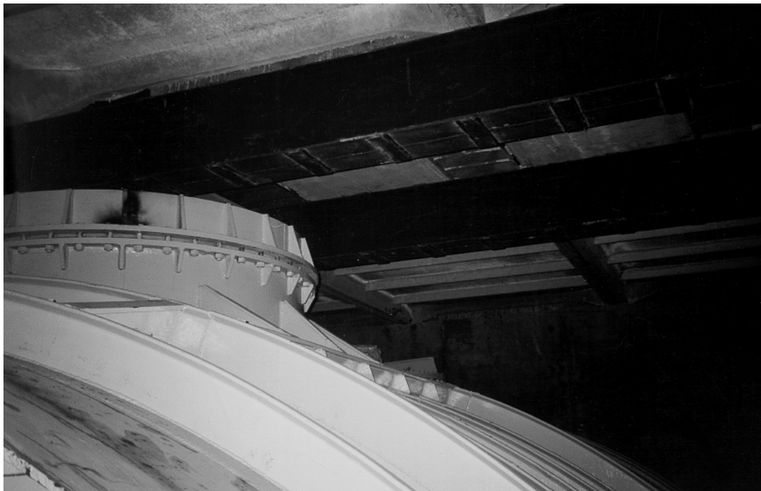
Foto 17. Paldiski Tuumaallveelaevnike Õppekeskuse tuumareaktorite korpused on kaetud betoonsarkofaagiga. Henno Putniku foto.
