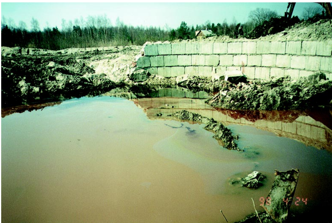
2 – Rohkesti naftajäätmeid sisaldava 200 m 3 suuruse kütusemahuti likvideerimine Paralepa lennuväljal. Tõnis Meriste foto.
