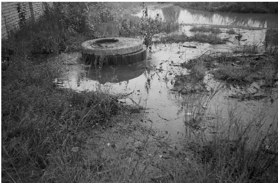
Foto 20. Peale vene sõjaväelaste lahkumist olid Tondi settekaevud ummistunud ja täitunud reoveega. Toomas Lambuti foto.
