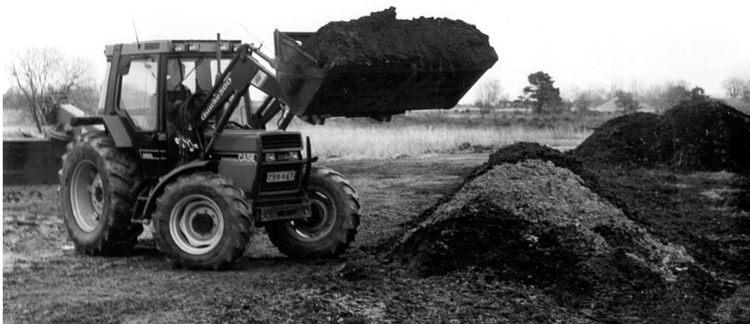
Foto 12. Naftaproduktidega reostunud pinnase aunadesse kogumine Keila-Joa raketibaasis. Hugo Tangi foto.
