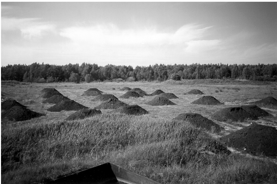
Foto 10. Samiini reostusest puhastatud pinnase tagasipaigutamine Keila-Joa raketibaasis. Tõnis Meriste foto.
