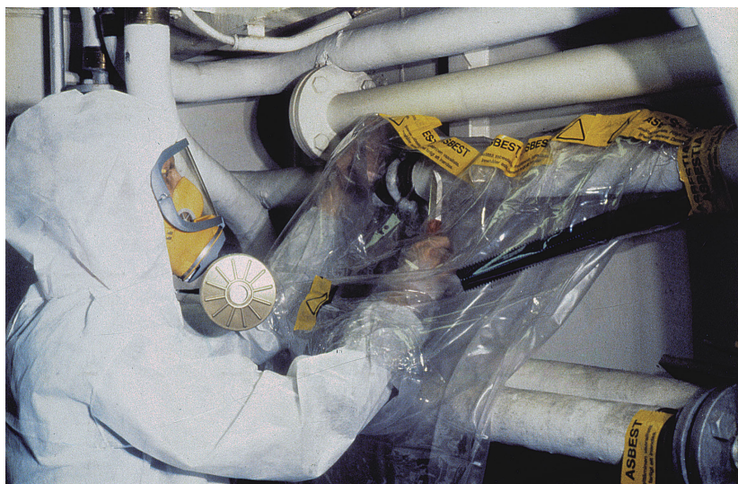
Foto 9. Juhani Jaakkola: Asbesti sisaldava isolatsiooni lammutamine.
