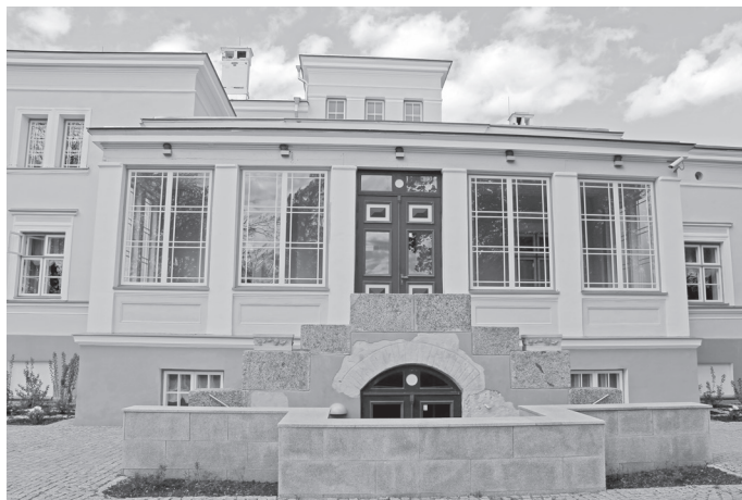
Saka mõis Foto: Tiina Kilumets
