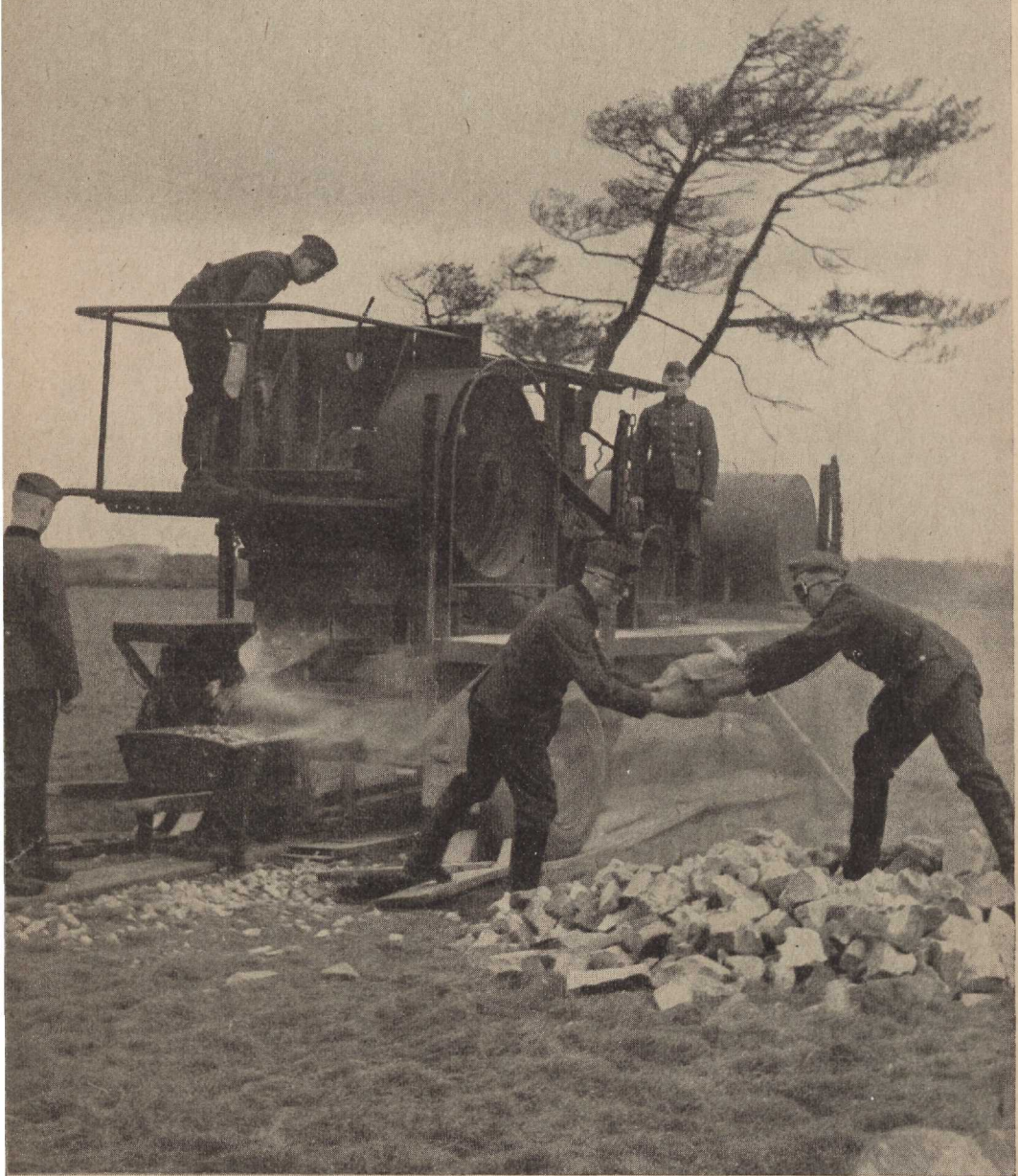
Kivilõhkumismasina meeskond on varustatud töö ajal kõikide tarvilike kaitsevahenditega.
