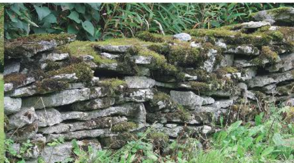
Vana kiviaed Saha kabeli ümber. Foto Heidi Tooming
