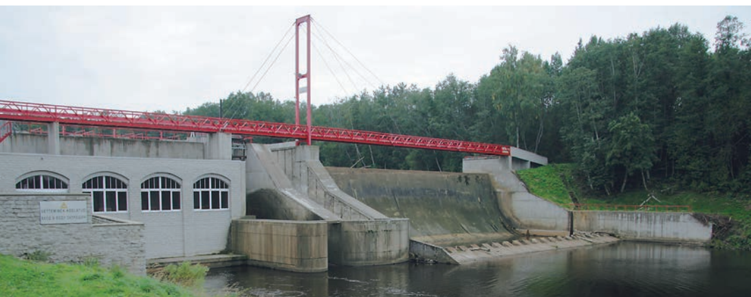
Taastatud Linnamäe hüdroelektrijaama pais. Foto Heidi Tooming
