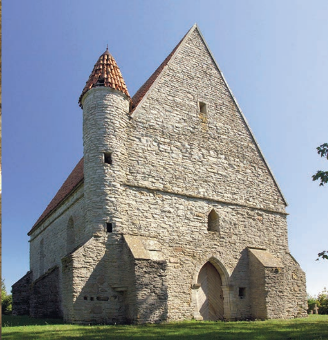
Kõrgel asetsevad aknad ja nurgatorn näitavad, et vajaduse korral võis kabel olla ka varjupaigaks. Foto Tiit Hunt
