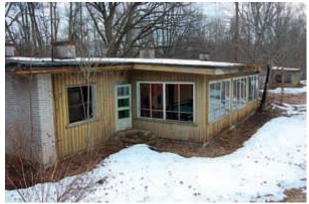
Foto 6. Nõukogude ajal rajatud pioneerilaagri magalad lammutatakse ja nende asemele rajatakse kärpmuruga parklad, 2011
