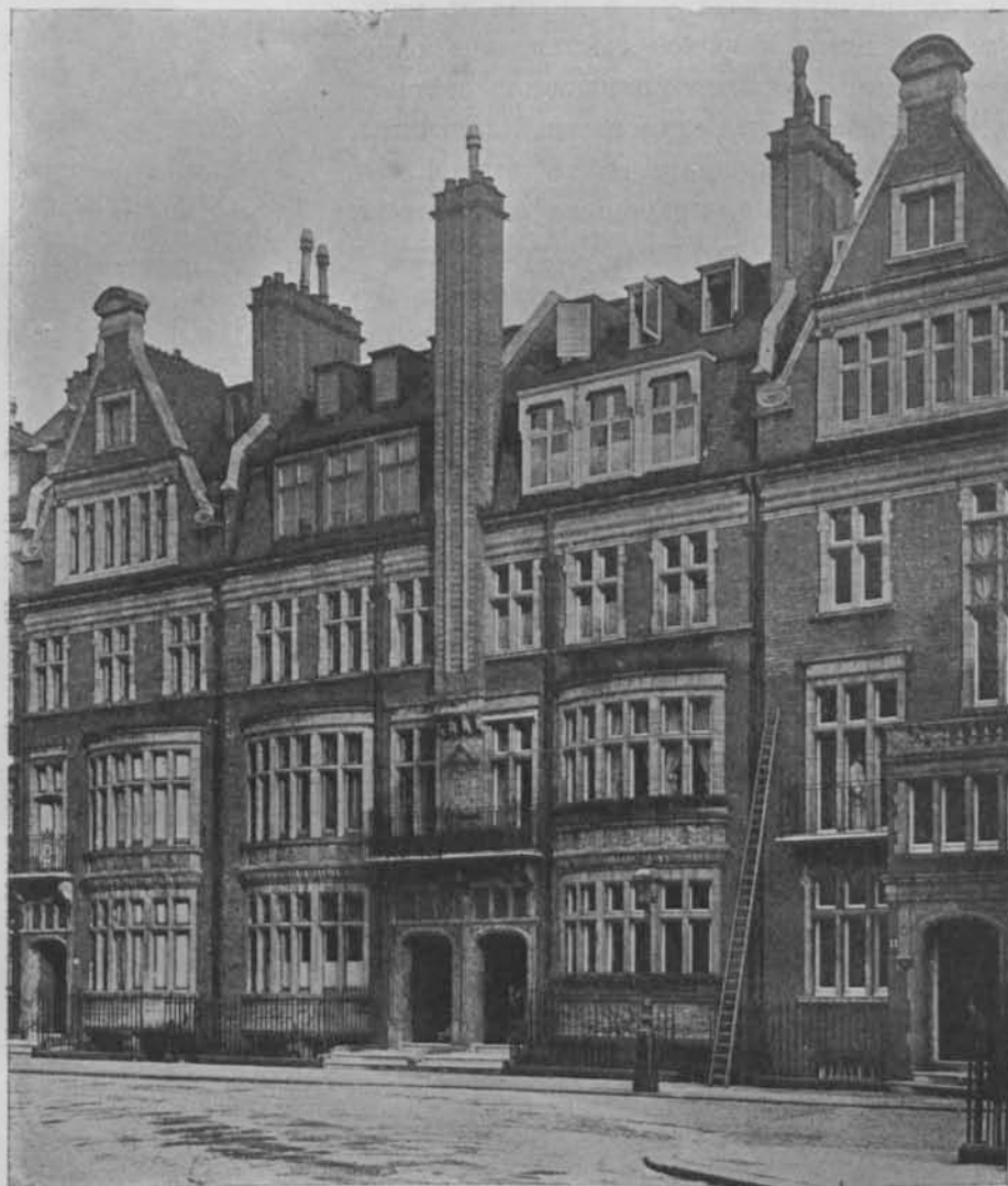
Фиг. 368 32 ). Лондонскіе дома особняки, застроенные съ двухъ сторонъ; арх. С. W. Stephans.
