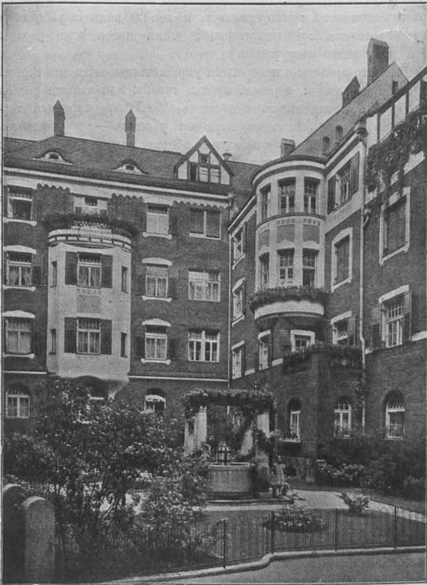
Фиг. 475 а ). Видъ двора доходнаго дома въ Мюнхенѣ; арх. Hennig и Seldner
