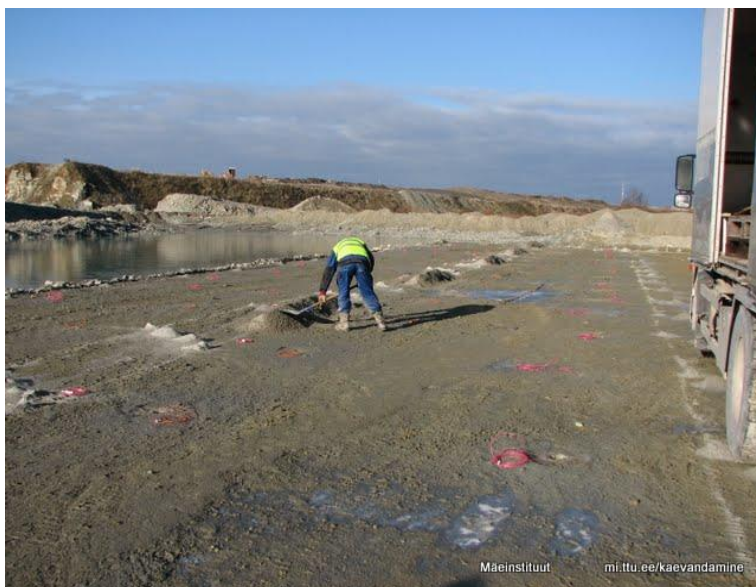
Joonis 46 Lõhkevõrgu monteerimine
