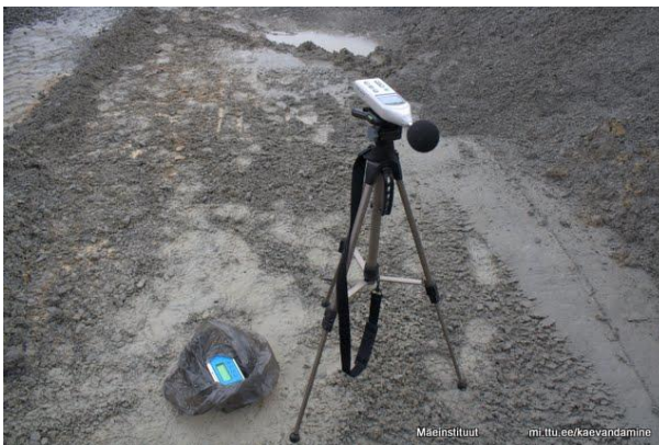
Joonis 41 Purustite vibratsiooni ja dolokivi raimatavuse mõõtmine
